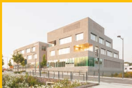
Stonedge - Immeuble de bureaux - Cesson-Sévigné (35)
